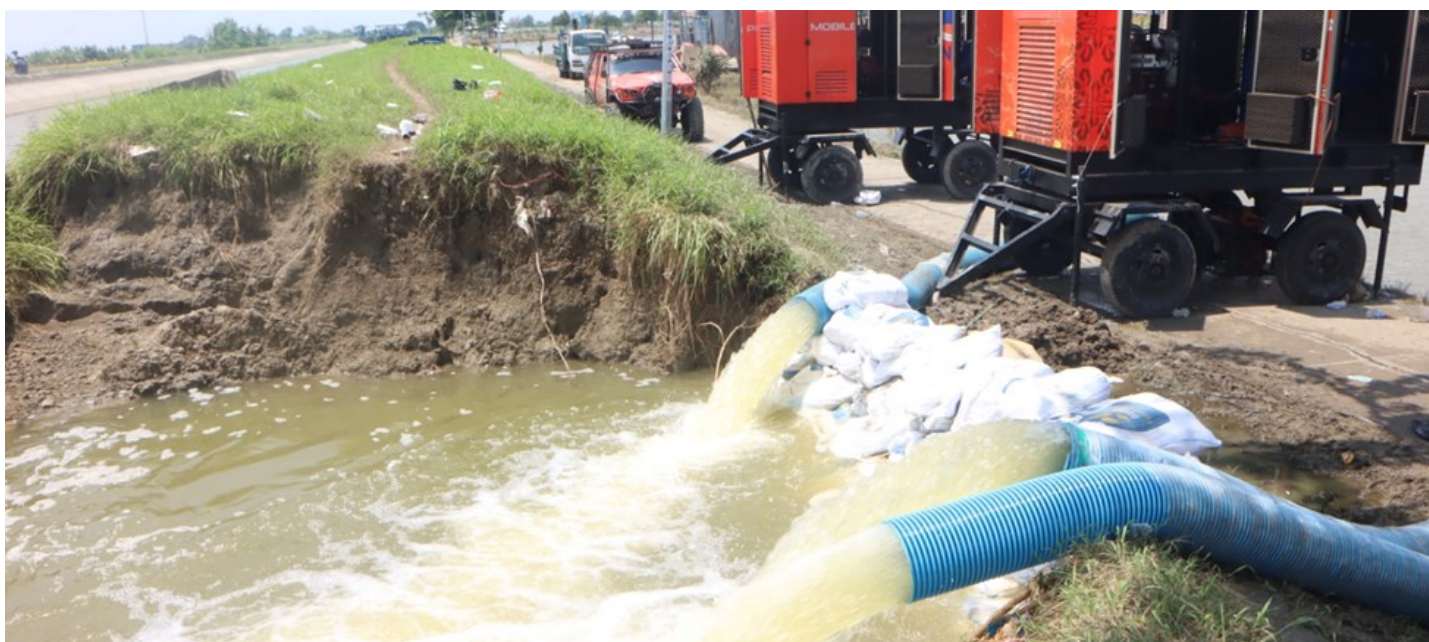
Gambar 10. Penanganan Banjir di Kabupaten Demak Menggunakan Pompa Air
